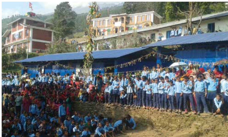
Mandali Secondary School di Phulkharka, edificio ricostruito e consegnato in ottobre 2016
