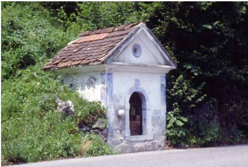
"Maino di Petiro" nel 1991 prima della ristrutturazione
